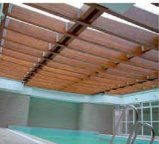
Su resistencia a los agentes químicos agresivos hacen de la madera un material difícilmente sustituible en piscinas cubierta, con un ambiente húmedo agresivo debido al cloro. Tan corrosivo para las estructuras metálicas o de hormigón, no supone, en cambio ningún problema para la madera.
