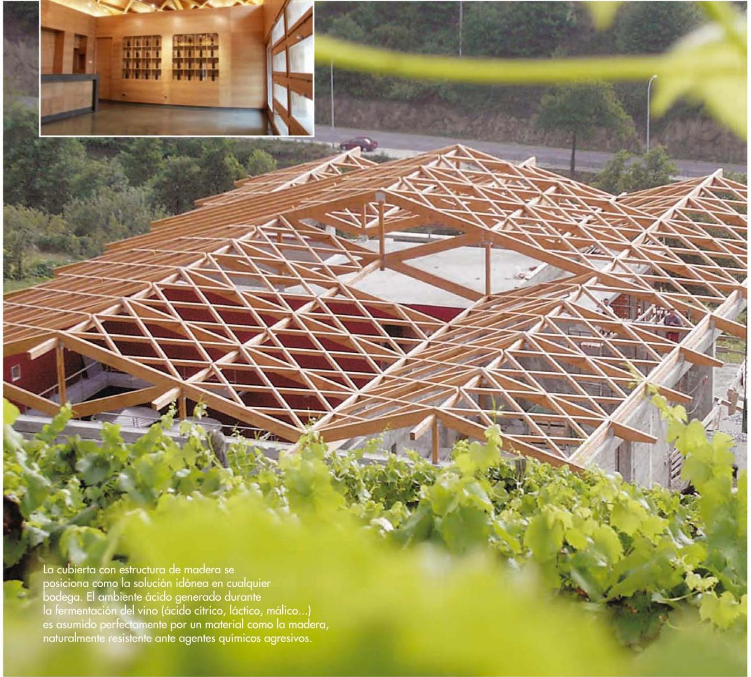
La cubierta con estructura de madera se posiciona como la solución idónea en cualquier bodega. El ambiente ácido generado durante la fermentación del vino (ácido cítrico, láctico, málico...) es asumido perfectamente por un material como la madera, naturalmente resistente ante agentes químicos agresivos.
