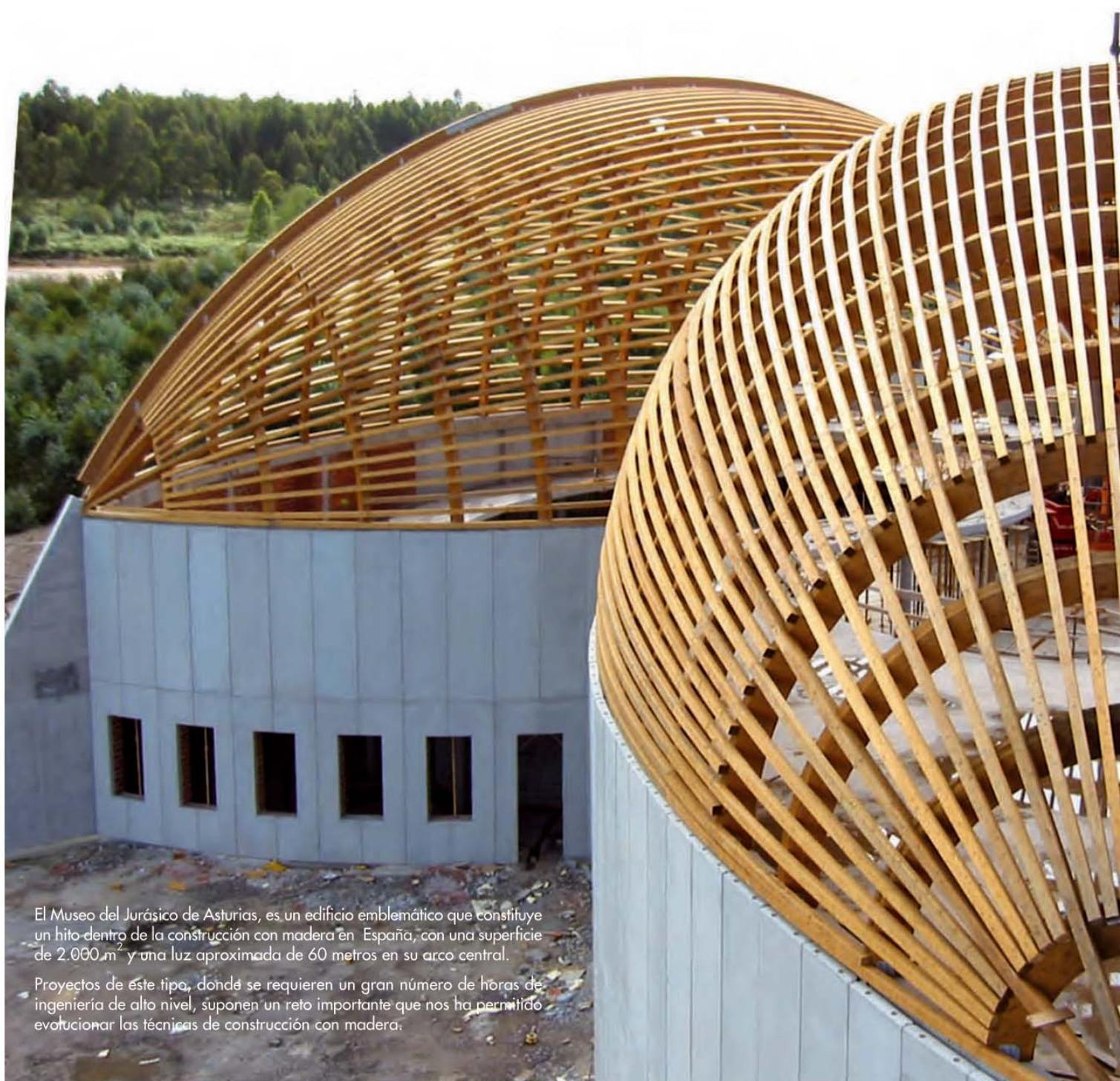
El Museo del Jurásico de Asturias, es un edificio emblemático que constituye un hito dentro de la construcción con madera en España, con una superficie de 2.000 m<sup>2</sup> y una luz aproximada de 60 metros en su arco central.
